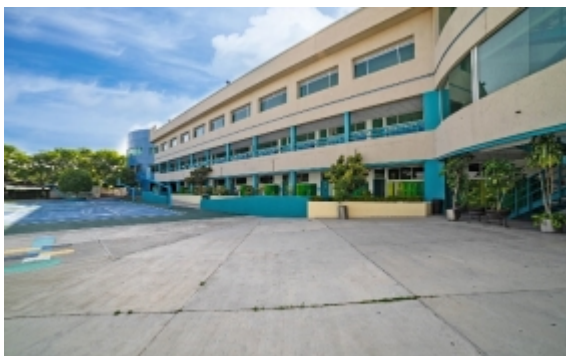
Ubicación: Corregidora, Querétaro ABR: 13,168 m² Terminación de obra: 2004
